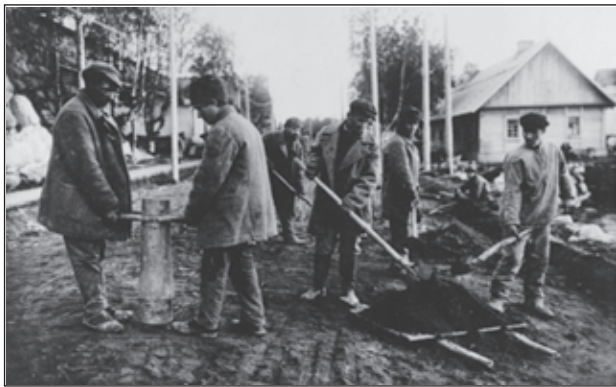
Соловецкий лагерь особого назначения. Заключенные выполняют дорожные работы. Фотография 1920-х годов
